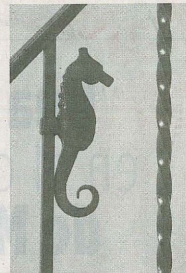
DETALLE DE LA BARANDA DE HIERRO FORJADO.
